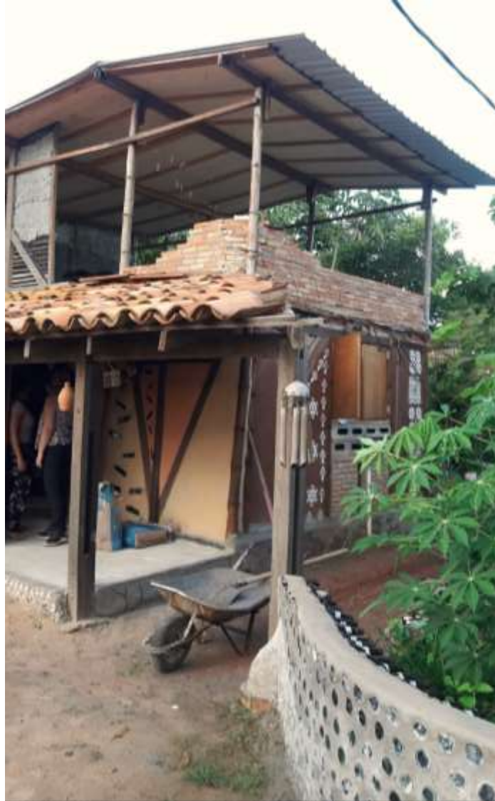
Fotografia 30 – Casa Bambuba em processo de Bioconstrução
