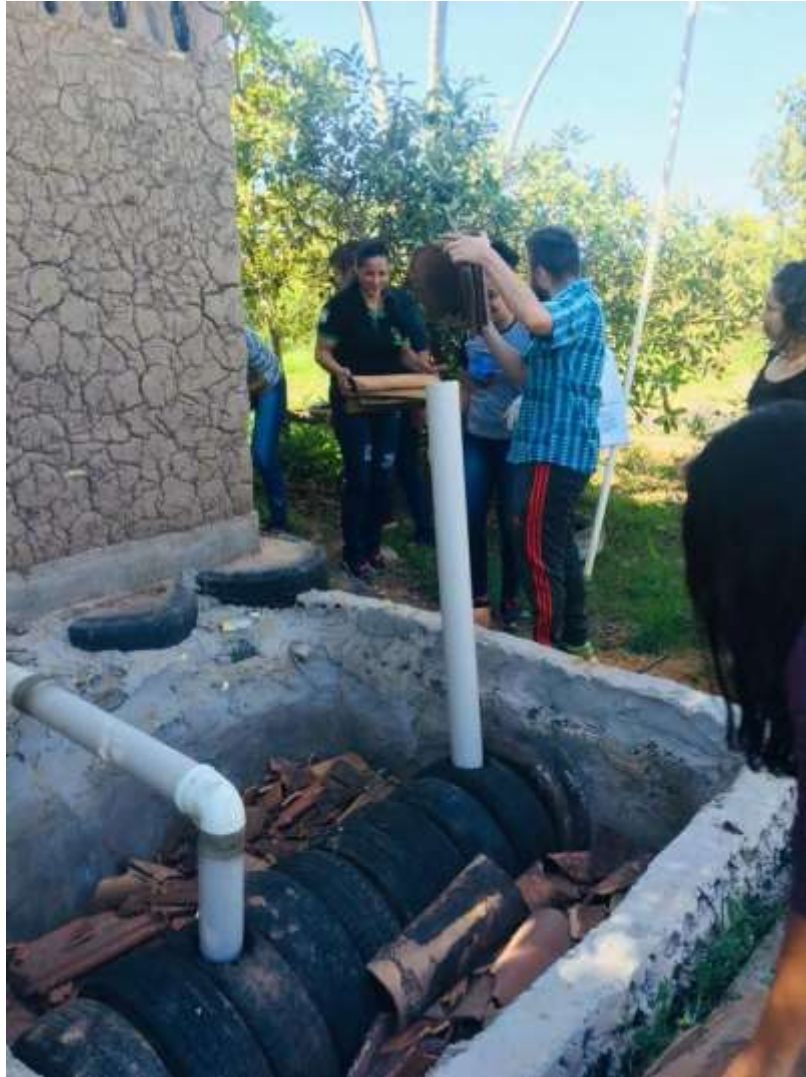
Fotografia 6 – Construção de fossa séptica para tratamento do esgoto de “banheiro seco”
