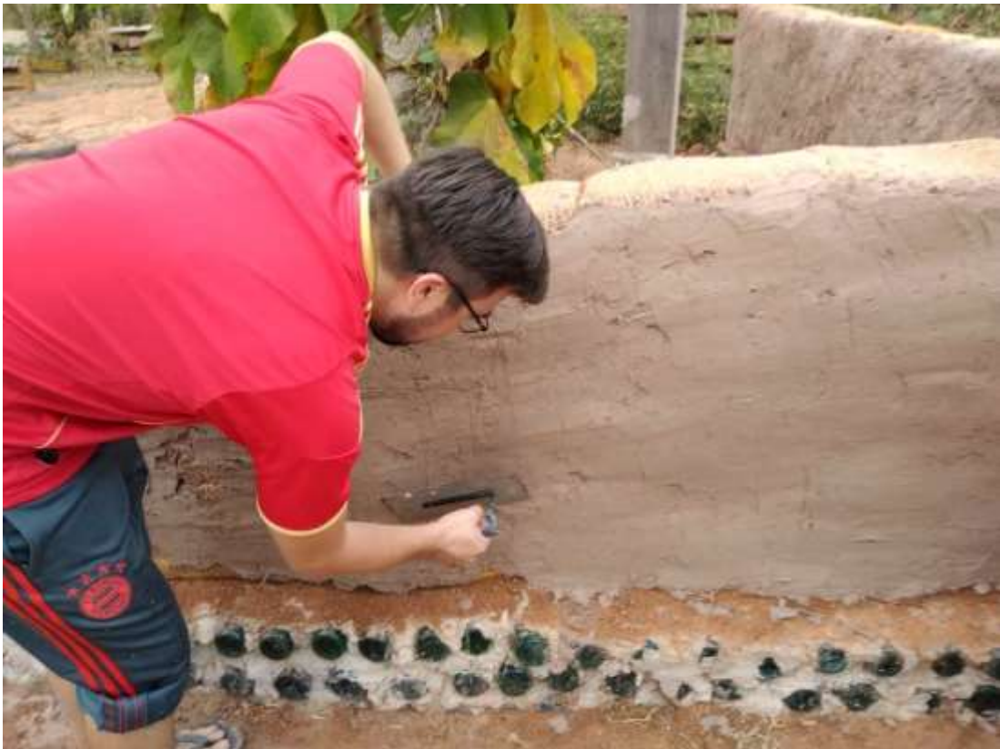
Fotografia 3 – Eu aplicando técnica de reboque em muro de hiperadobe sobre base de garrafas
