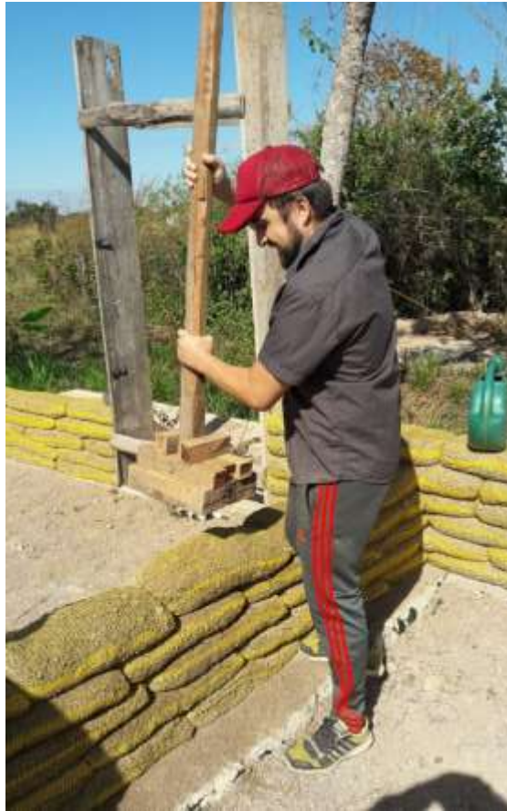
Fotografia 4 – Compactação de sacos de hiperadobe para paredes de casa na Ecovila
