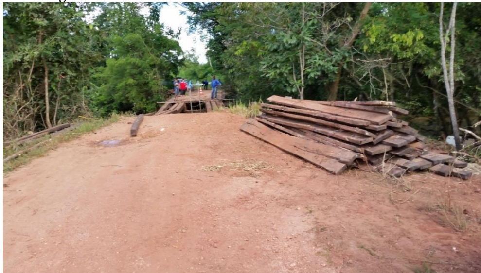
Figura 2 – Ponte do assentamento Roseli Nunes sendo consertada
