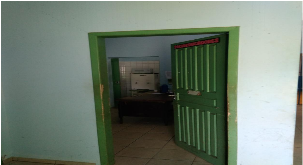
Fotografia 7 - Sala de apoio aos socioeducadores (Nessa sala os socioeducadores registram, no livro, as ocorrências e podem acompanhar as câmeras de segurança e descansar um pouco)
