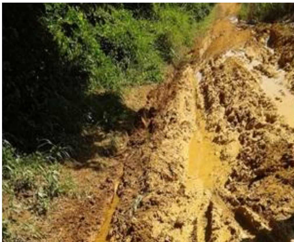
Figura 39 - Estrada da Linha Doze. Acesso à Terra
